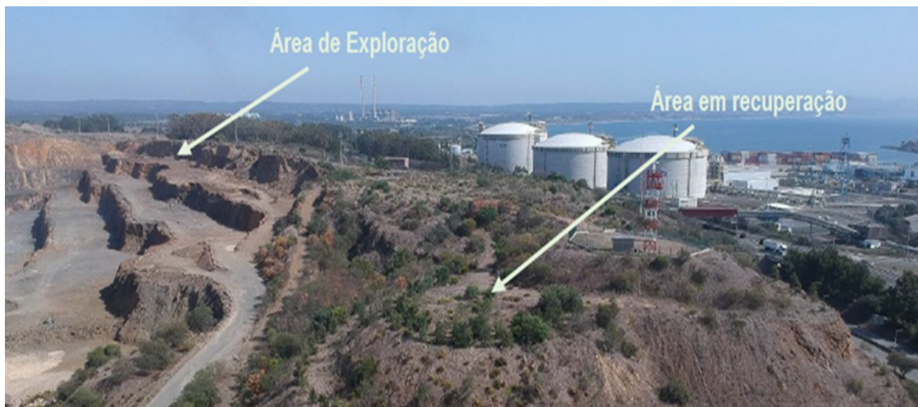
Figura 12 - Armazenamento do Gás Natural Liquefeito a 297 m do Projeto (figura II.13 EIA)
