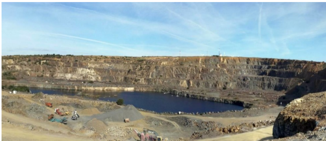
Figura 9 - Vista da água acumulada no fundo da corta na frente da lavra ativa (Figura III.72 do EIA)
