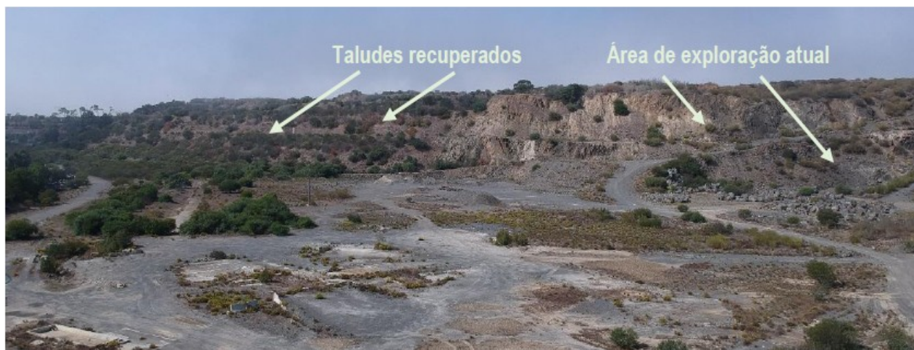
Figura 4 – Pedreira com áreas recuperadas e em exploração (Figura II.12 do EIA)
